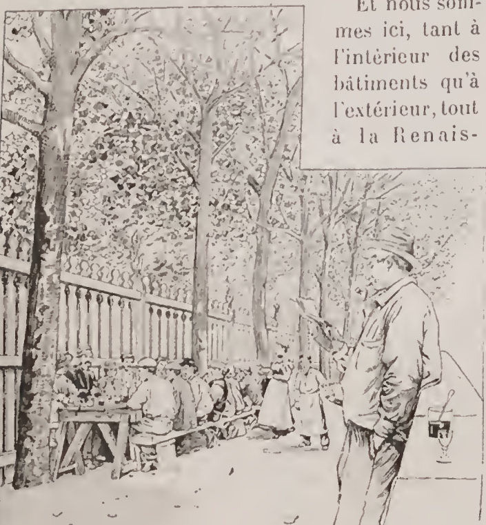
LE VIEUX PARIS. — Le repas des ouvriers.
